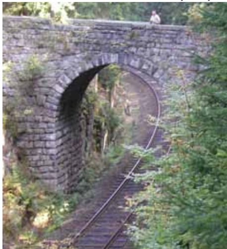
Klenba Ovčích mostu nad Tisovou spolu s kolejemi symbolizuje svou „dvojkou“ druhou nejvýše položenou železniční trať v ČR. Foto: Milan Michálek (2008)
