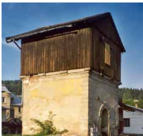
Stará vodárna na nejdeckém nádraží sloužila ke „zbrojení“ parních lokomotiv. Foto: Milan Michálek (1999)
